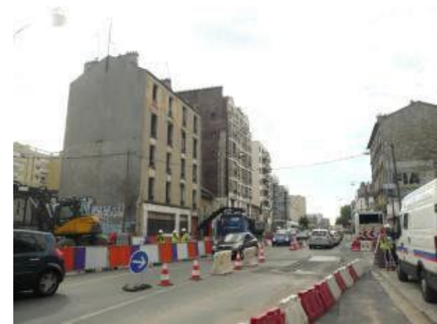
Travaux le long de la RD5
