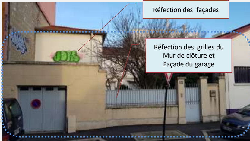
DP 07 Vue du mur de clôture et de la façade du garage – ETAT EXISTANT
