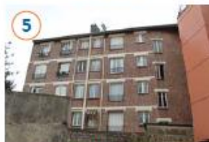
5 IMMEUBLE MITOYEN DONNANT SUR LE PARC DE STATIONNEMENT
