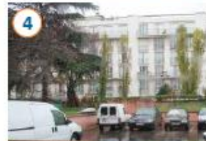
4 IMMEUBLE MITOYEN DU FOND DE PARCELLE
