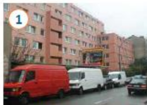
1 FAÇADE DU FTM DONNANT SUR LA RUE
