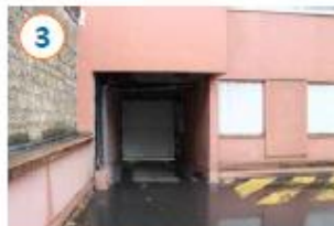
3 PORCHE D'ACCÈS AU PARKING
