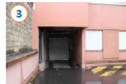
3 PORCHE D'ACCÈS AU PARKING
