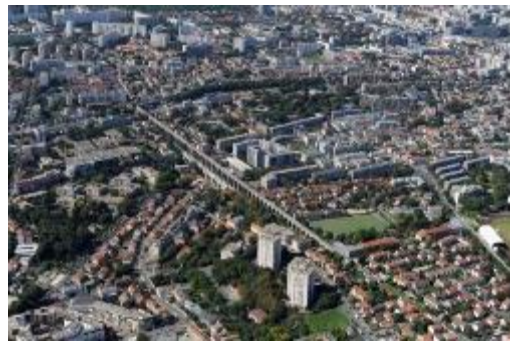
Aqueduc de la Vanne à Arcueil/Cachan Source : APUR, 2016
