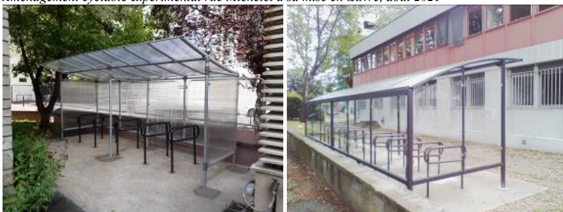
Abris installés à Cachin et à l'annexe Coutant au printemps 2021
