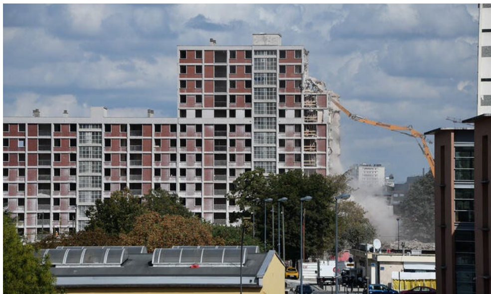
Immeuble Gagarine en cours de déconstruction – Source : Mairie d'Ivry-sur-Seine - David Merle
