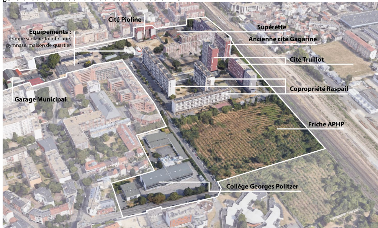
Le bâti avant la démolition de l'immeuble Gagarine – Source : GoogleEarth 2019
