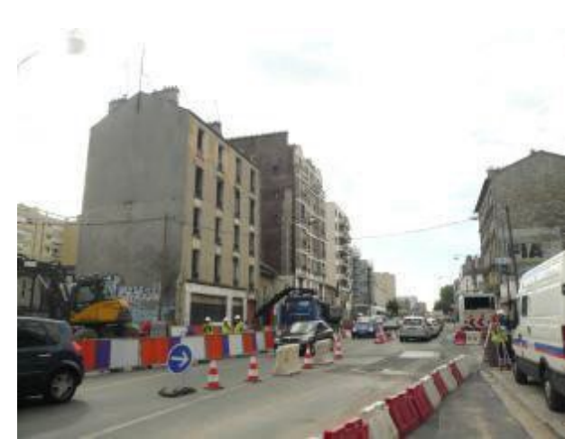
Travaux le long de la RD5
