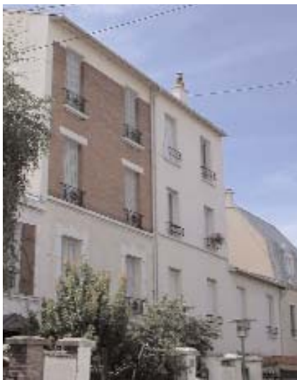
Surélévation ancienne à R+3+C
