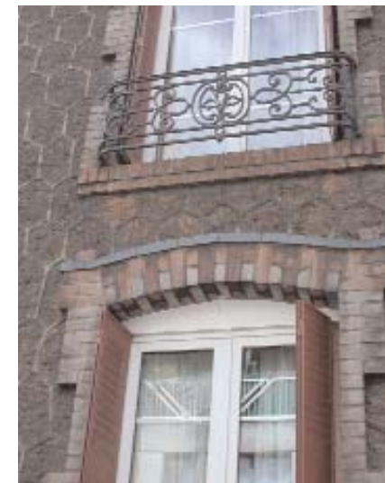
Détail des joints et des modénatures
