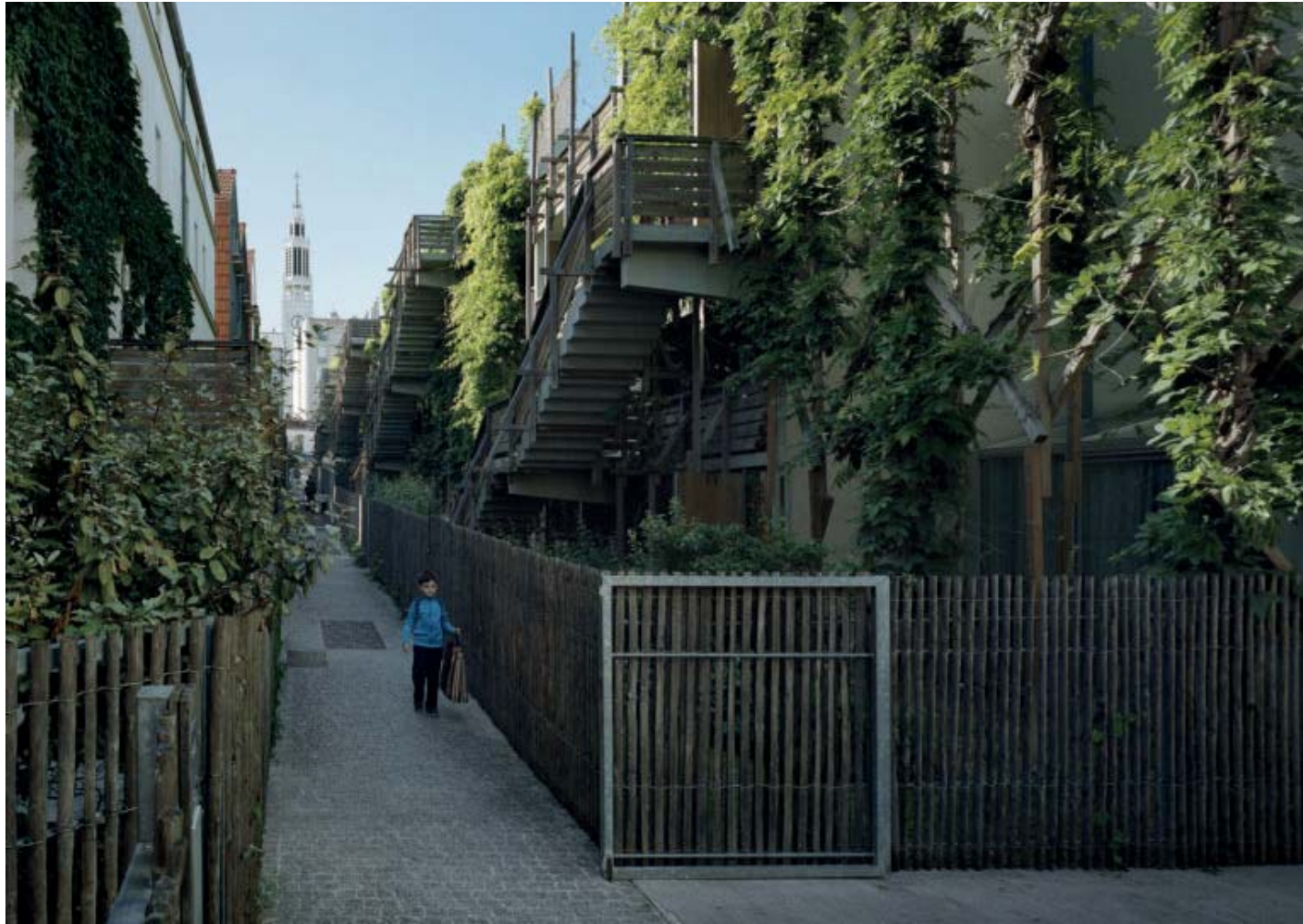
▲ EDOUARD FRANCOIS - LOGEMENTS - PARIS 20, FRANCE ▼ ATELIER DU PONT - LOGEMENTS - IVRY, FRANCE
