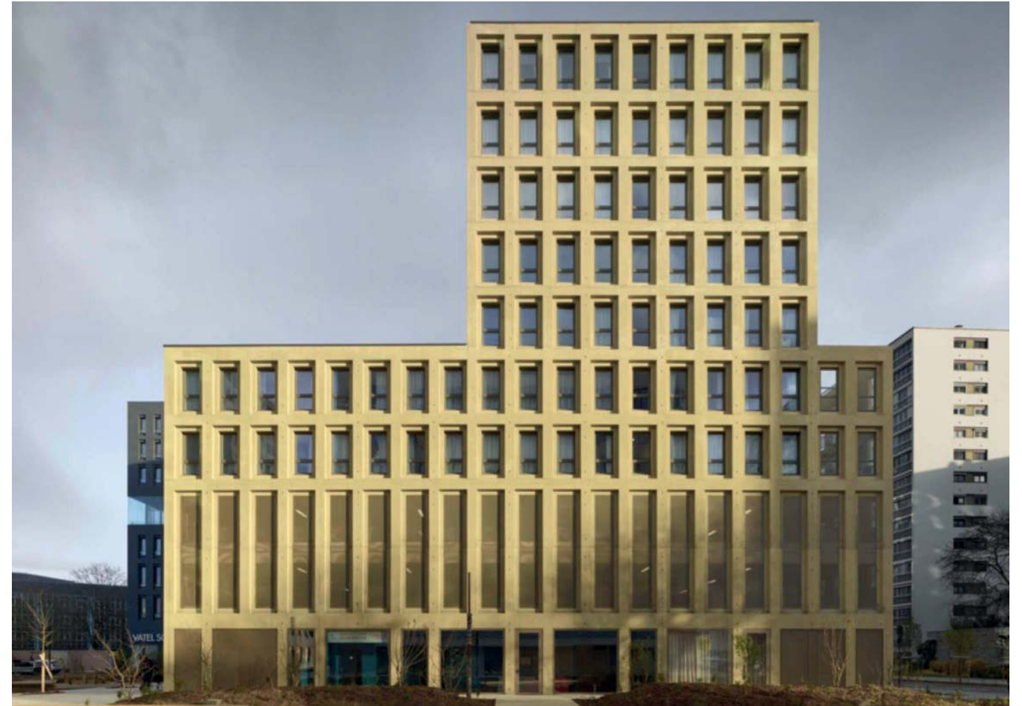
▲ LAN - LOGEMENTS ÉTUDIANTS, ÉCOLE HÔTELIÈRE, CAFÉ VATEL ET PARKINGS - NANTES, FRANCE ▼ NRAU - ZAC DE LA PORTE DE VALENCIENNES - LILLE, FRANCE
