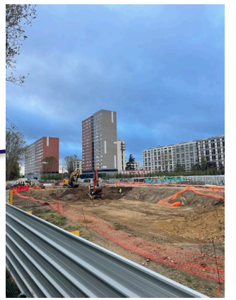
Lot Gare (9) Travaux de terrassement en cours
