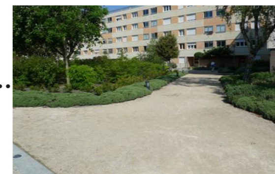
Allée piétonne en stabilisé renforcé
