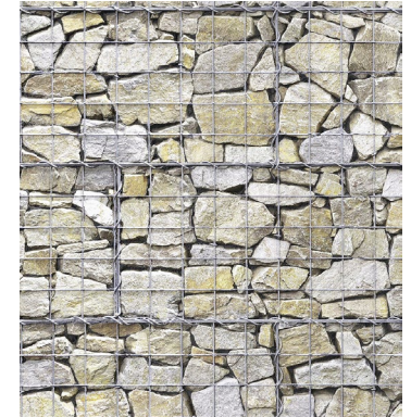
Gabion en RDC de béton de réemploi
