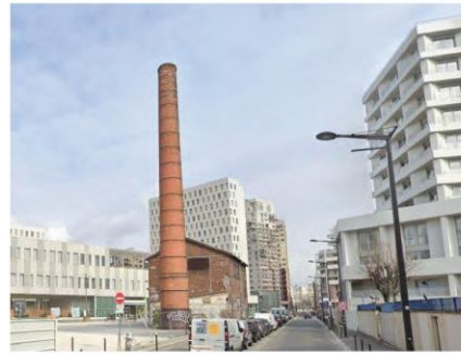
Bât BHV _ cheminée chaufferie BHV
