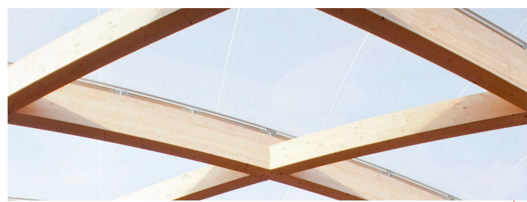
Couverture en ETFE Matériau de synthèse et coussins d'air
